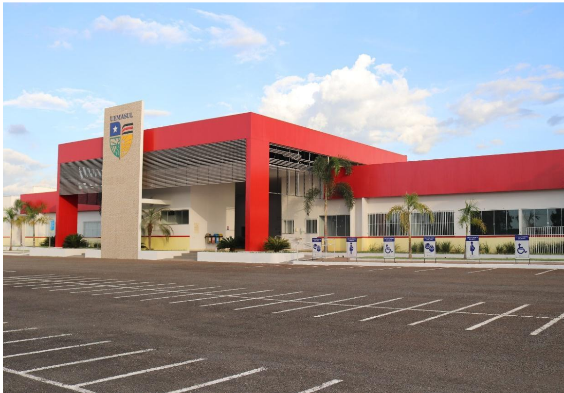
Figura 5 - Fachada do Centro de Ciências Agrárias, Naturais e Letras – CCANL, Campus Estreito.
